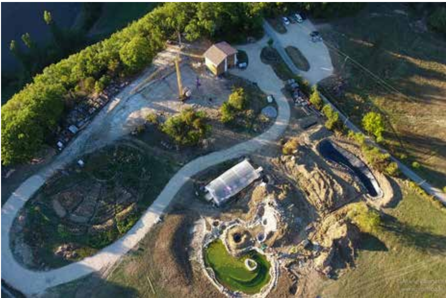
captage et stockage des eaux
